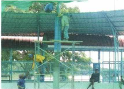
ฝ่ายงานสถานที่ อาคารหลังที่ ๓ แก้ไขลรอยรั่วหลังคา บริเวณอุโมงค์เทียม
